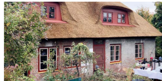
Richtfest am reetgedeckten Fischerhaus
