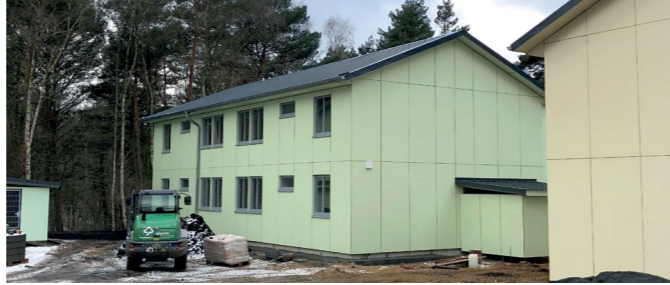
Noch Baustelle, bald voller Leben: Pavillondorf am Björnsonweg
